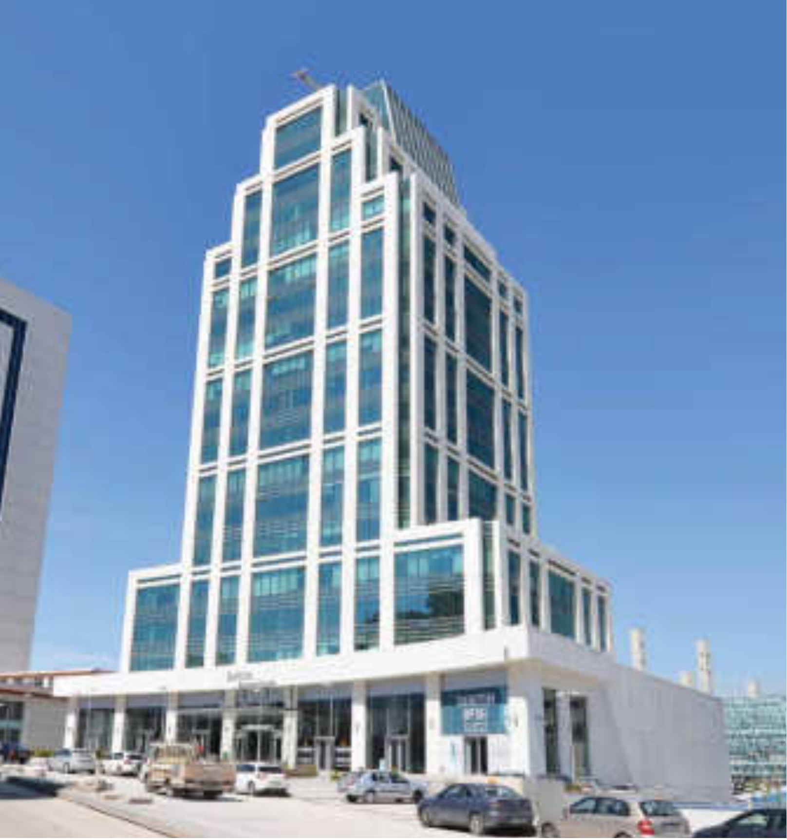
Kazan dairesi iç Tesisat Yapımı ve Projelendirmesi İşi Boiler, interior Line installation and project desing
