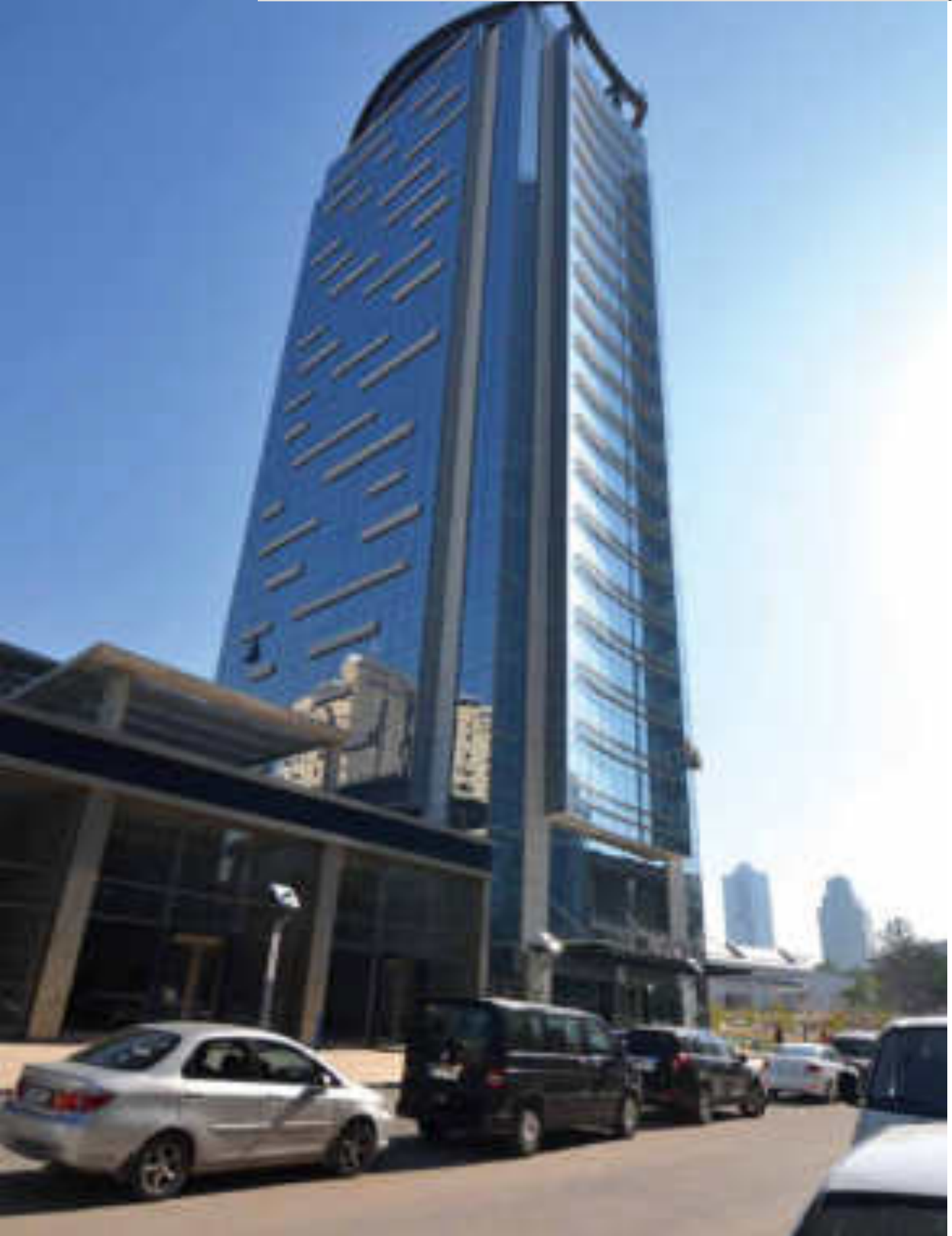
Anahat, Servis Hattı Yapımı ve İstasyon Kurulumu İç Tesisat Yapımı ve Projelendirmesi İşleri Outline, Service Line and Reglaj Station Installation
