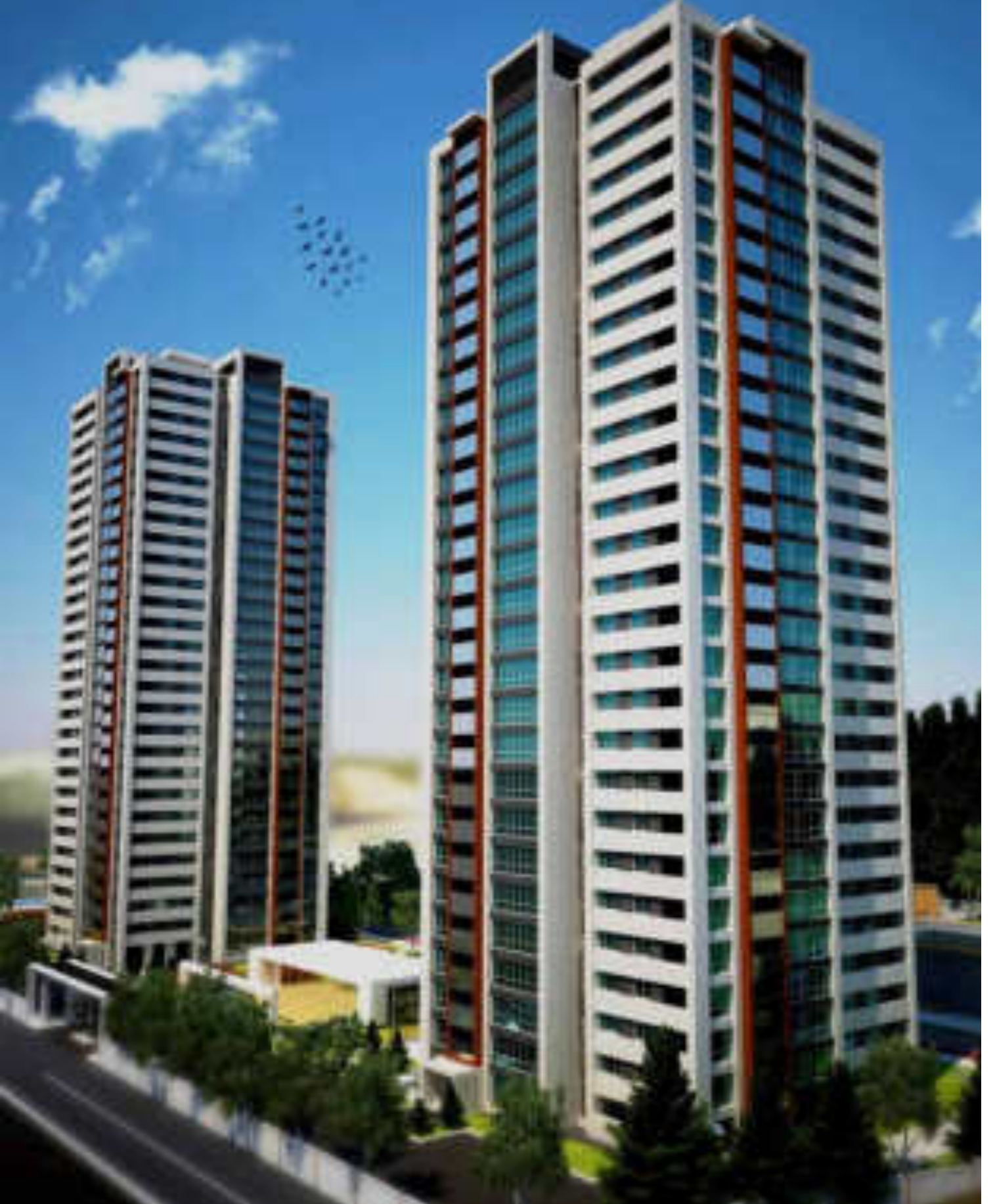
İç Tesisat Yapımı ve Projelendirme İşi Interior Line installation and project desing
