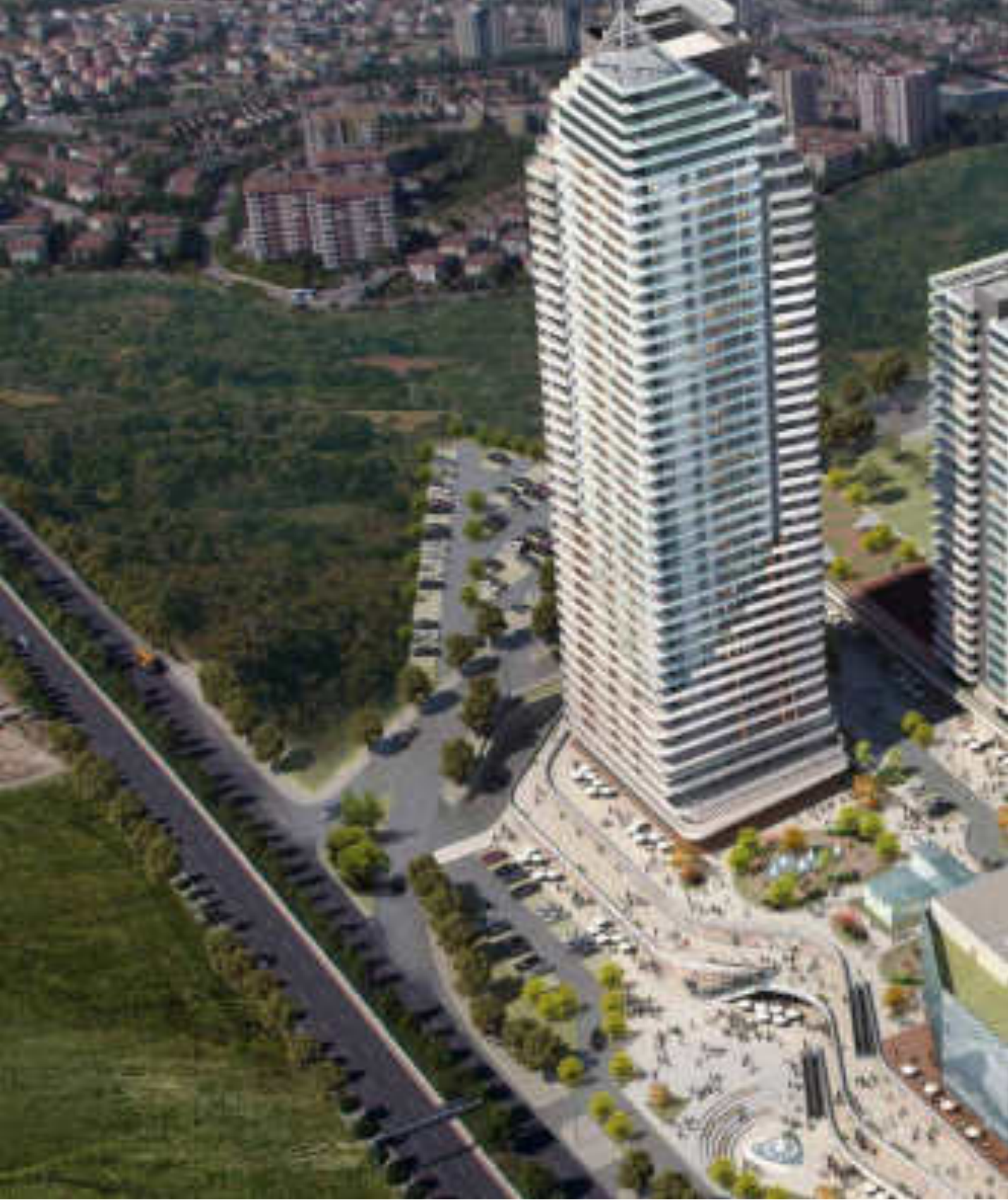
Doğalgaz altyapı, iç tesisatları (Kazan, Kolon) uygulama ve projelendirilmesi işleri Natural Gas infrastructure, Service Line, Boiler, interior Line Installation and Project Design
